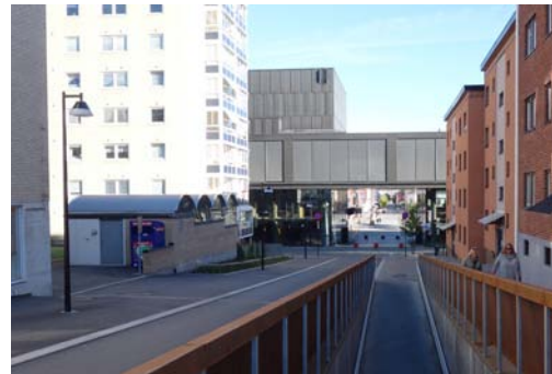
God integrering av passasje til parkeringsanlegg i gate og siktlinjeføring, samt harmonerande materialbruk.
