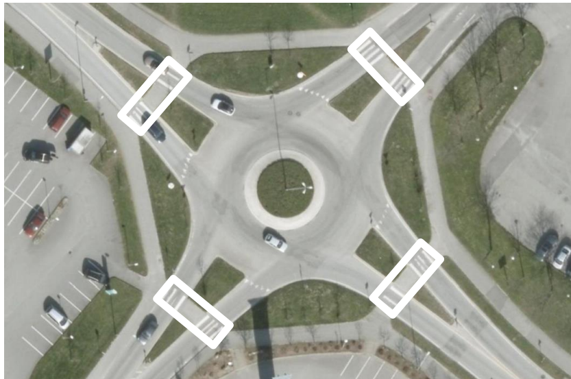
Figur 37 Etablering av opphøyde fotgjengerkryssinger i rundkjøringen Bernervegen x Torggata.
