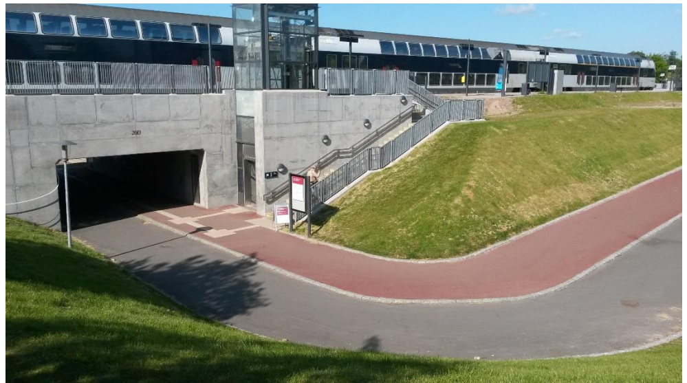
Figur 42 Eksempel på bred kryssing av jernbane med både fotgjenger- og sykkel-forbindelse. Hvalsø stasjon, Danmark.
